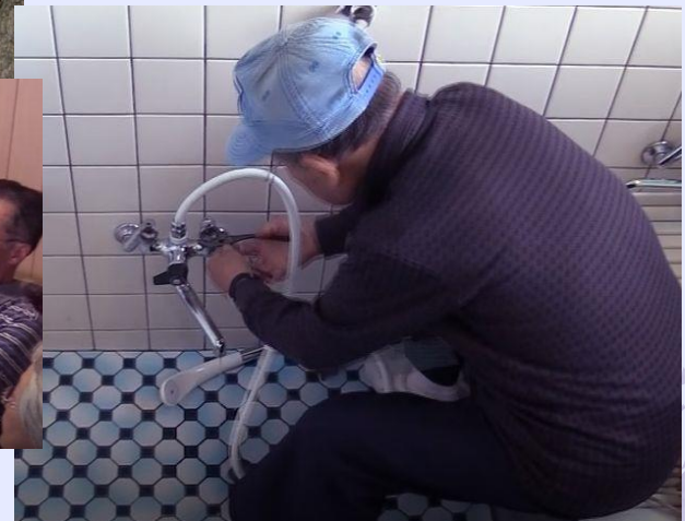
パッキン交換
